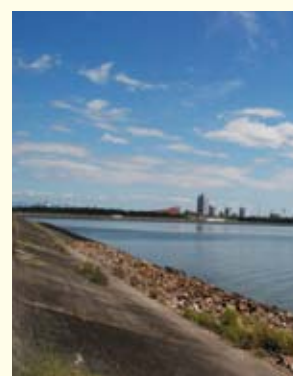
コンクリート護岸で整備された河口
