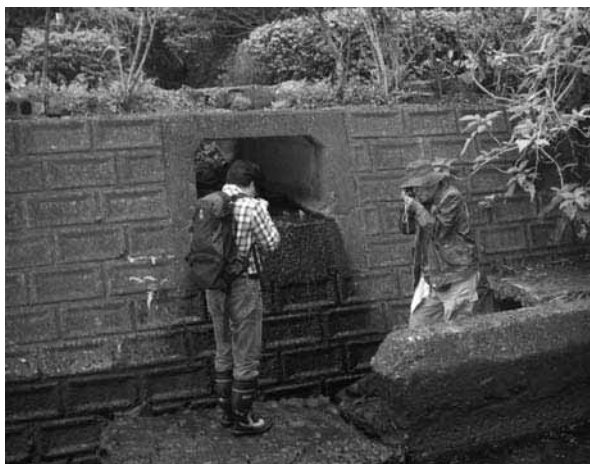
図20：小支流に注ぐ水路。 小さなボックスカルバートから少量の清水が流れる。ブロック護岸全面を紅色にペイントしたようにタンスイベニマダラが繁茂密着していた(図-3を参照)。
