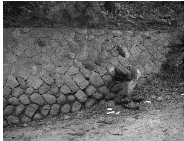
図16：河口域左岸側の石積み護岸。その基部の隙間にタニコケモドキ(紅藻)が生育(図版 -5を参照)。
