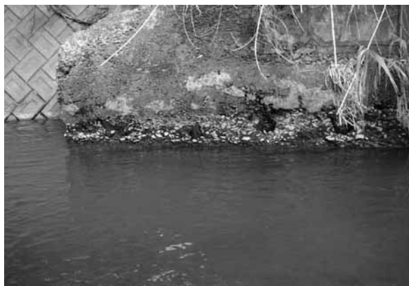
図12：島間川河川にかかる旧島間川橋の下の護岸。護岸表面にタニコケモドキが着生。
