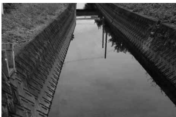
図27：消防分駐所(写真の左側)の側を走る用水路。この用水路(橋から下流側)。図23参照。
