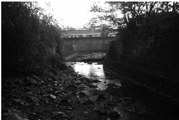
図12：安房川へ注ぐ小支流。
