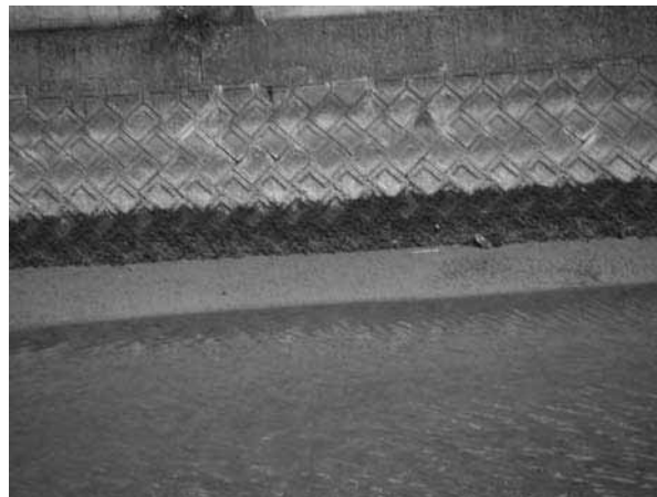
図39：前田川左岸側のブロック護岸基部の黒褐色に一部にアヤギヌ属の藻類が着生しているものと考えられる。
