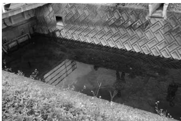
図28：橋の直ぐそばの用水路の様子(橋から上流側)。(吉田撮影)
