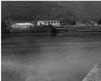
図31：河内川に流入する左岸側の小川の河口。護岸中央に見える暗きょうの部分。
