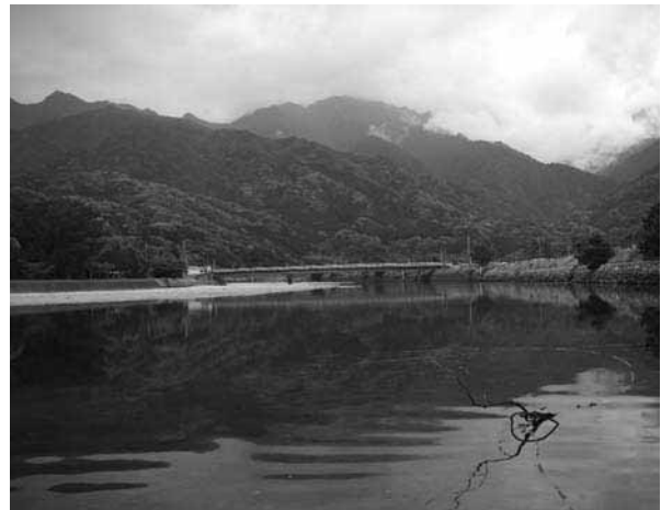
図18：永田川河口から眺めた永田橋。その護岸の壁にホソアヤギが着生。
