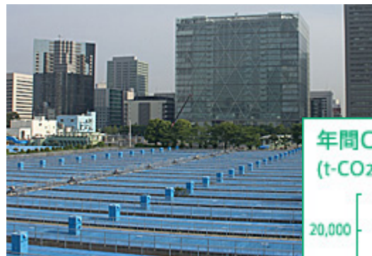
東京都下水道局 芝浦水再生センター
