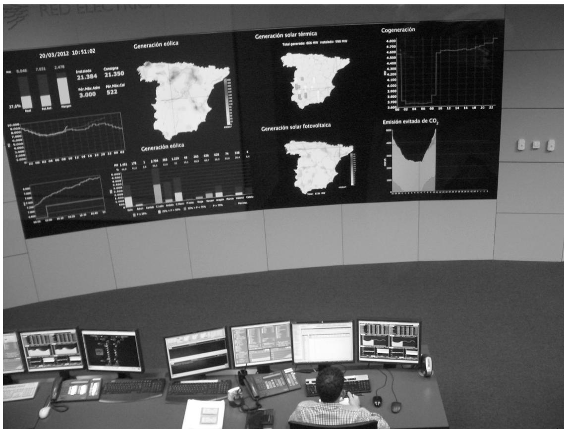
スペインの系統運用会社REE（Red Eléctrica de España）の運用する自然エネルギー専門の制御センターCECRE。スクリーンにはCO<sub>2</sub>排出量のリアルデータも映し出される（右下）
