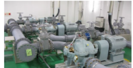
浄水場全体の電力使用量の6割を占めるポンプ場
