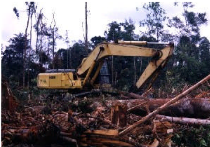
Figure 7. グループWのプロ的な活動に使用された掘削機。2003年6月1日撮影。
