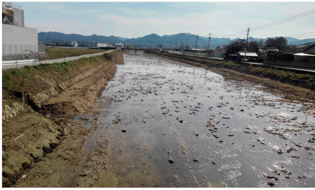
図1 平らに浚渫した直後（左：2019年2月撮影）と1年後（右：2020年8月撮影）の様子
