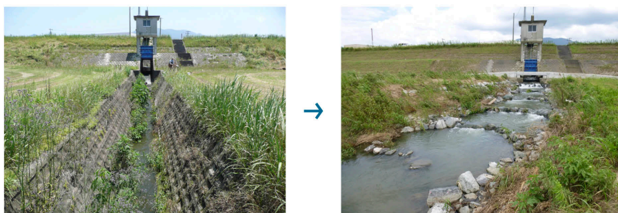
図4 エコロジカルネットワーク推進事業で横断方向の連続性を回復した事例（左：改修前、右：改修後）。
