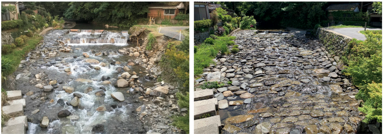
図1 石置堰の景観。平成30年に被災した直後(左)と復旧後(右)。石と石の組み合わせによる耐力で強度を保持している。
