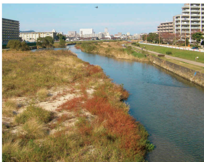
図2 滞筋を保全した浚渫の事例（室見川）
