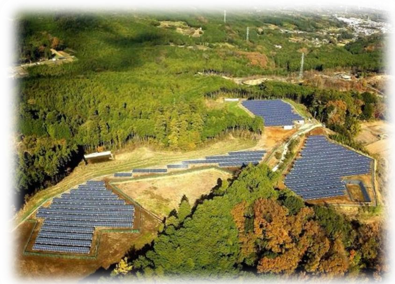
小田原メガソーラー市民発電所 上空写真
