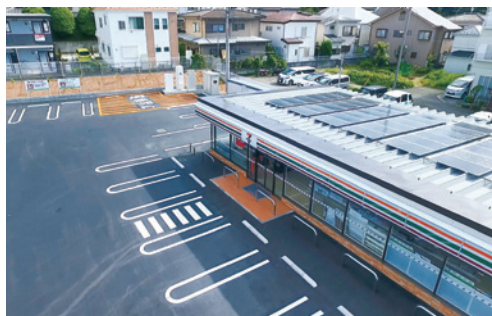
省エネ・創エネ・蓄エネ設備をさまざま組み合わせた店舗展開を行っている(写真は横浜市内のセブン-イレブン店舗)
