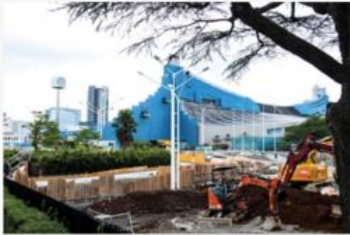
国立代代木競技場建設現場
