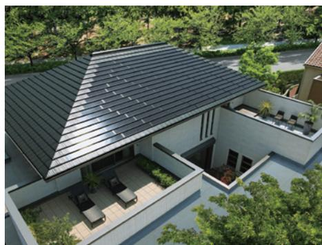
屋根には瓦型の太陽電池モジュールが設置される。エネルギー収支ゼロの家「グリーンファースト ゼロ」
